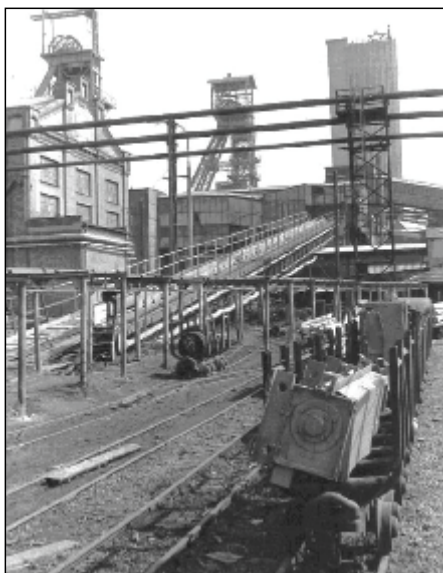
Obr. 1 Oběh vozů a závěsná doprava u jámy PG 2, 80. léta 20. století
