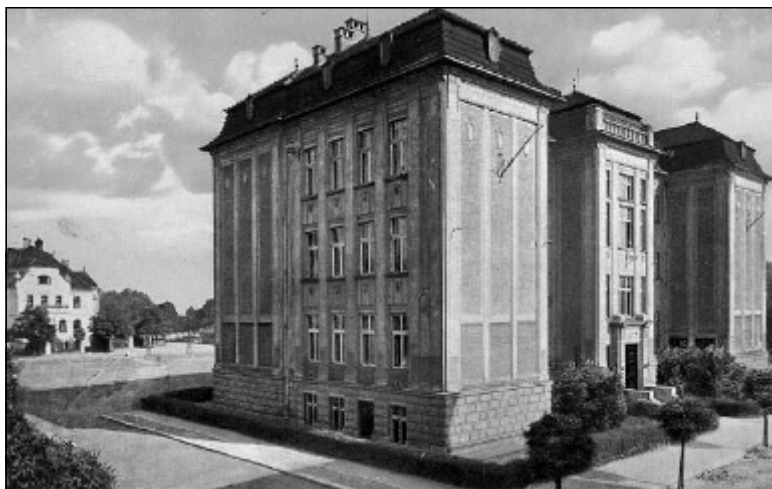
Obr. 2 Nová školní budova Průmyslové školy hornické na Kratochvílově ulici je z roku 1960
