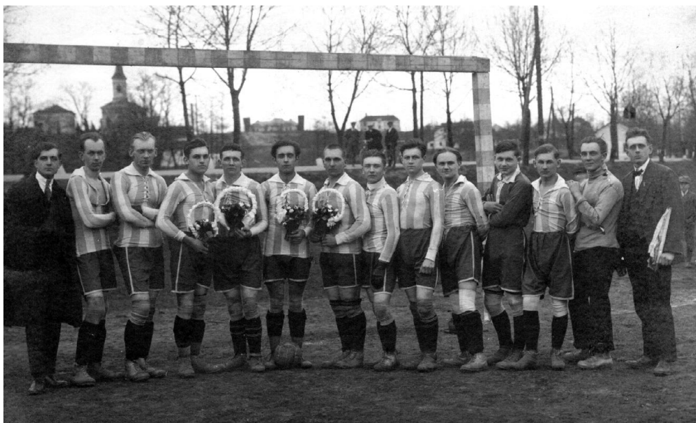
A – V pozadí katolický kostel a fara B – na pravé straně větrná jáma jámy Suchá C – zcela vpravo dělnická noclehárna jámy Suchá
